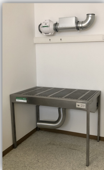
Frishluftzuführung über Absaugtisch
